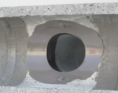
Das KA-TE-Schalungs-System ist ein Verfahren, mit dem u.a. Hausanschluss-Einbindungen dauerhaft und kraftschlüssig repariert werden können. Das Verfahren war und ist eine der entscheidenden Innovationen für die Reparaturverfahren mit Roboter-Systemen.
