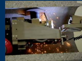
ZULÄUFE ÖFFNEN IM SCHLAUCHLINER STAHLANKER ABTRENNEN
